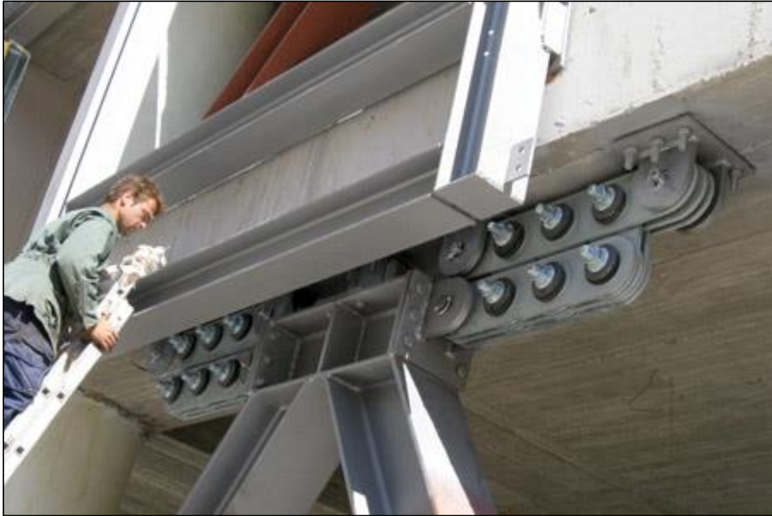
شکل ۱۱: کاربرد میراگر اصطکاکی دورانی در بادبند سازه بتنی
