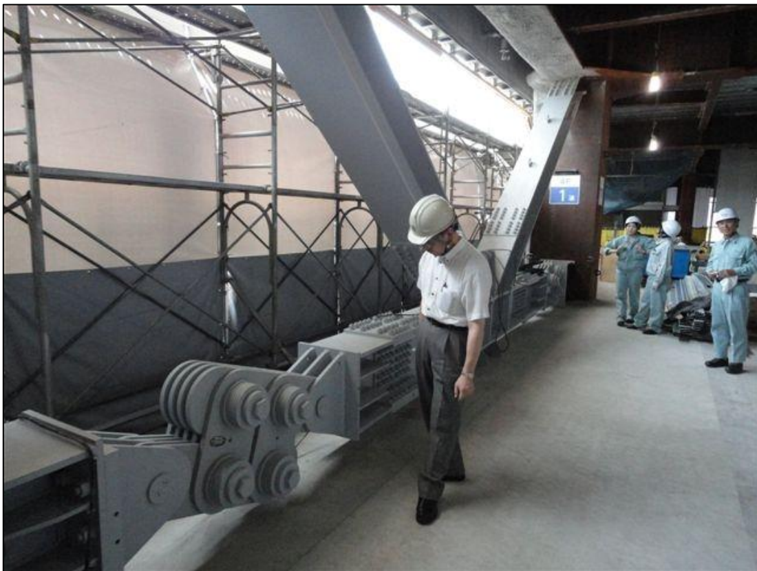
شکل ۱۲: کاربرد میراگر اصطکاکی دورانی در بادبند سازه فولادی
