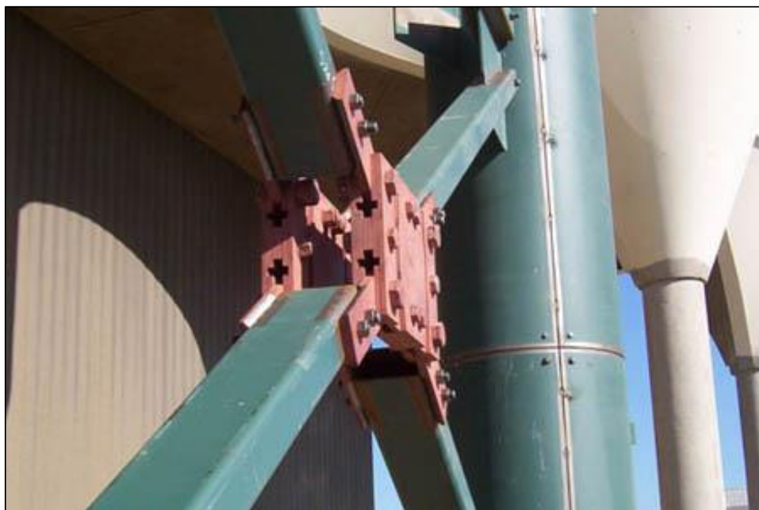
شکل ۵: میراگر اصطکاکی پال در مهاربند ضربداری
