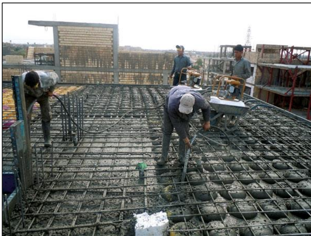
شکل ۷: ویریه زدن بتن
