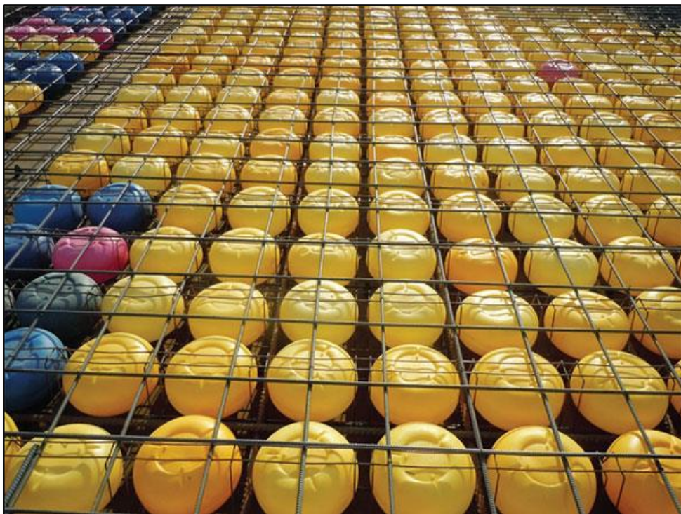
شکل ۵: مش‌بندی سفره آرماتورهای بالایی
