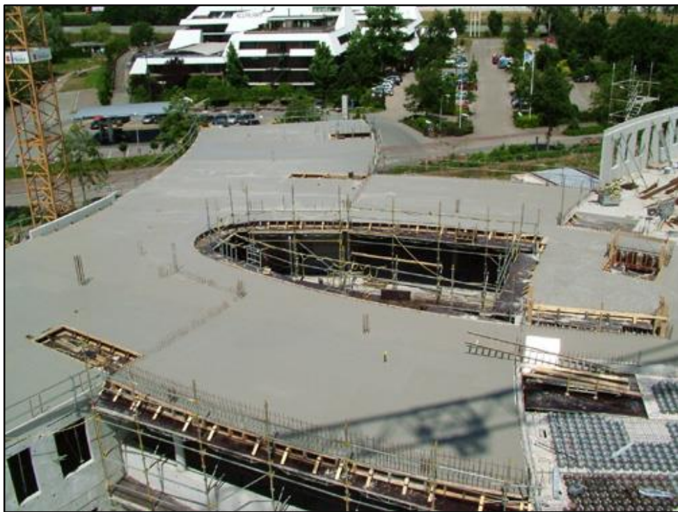
شکل ۹: نمای نهایی سقف
