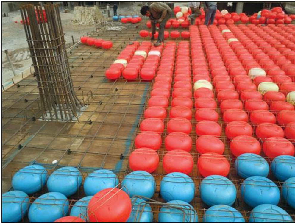
شکل ۳: نصب کوبیاکس‌ها
