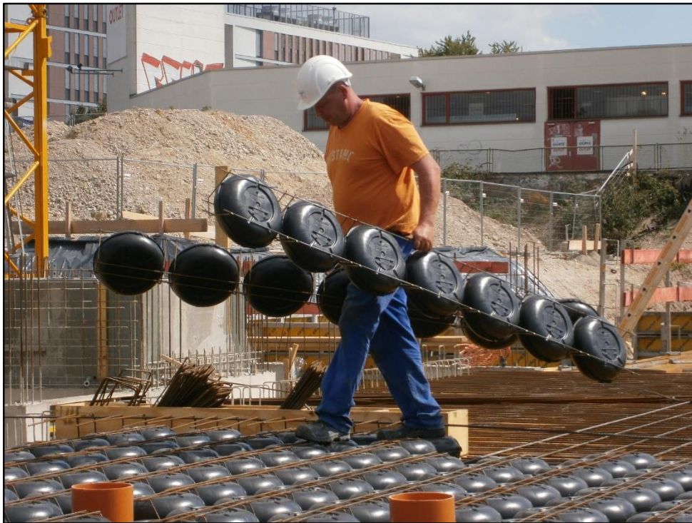
شکل ۴: نصب کوبیاکس‌ها
