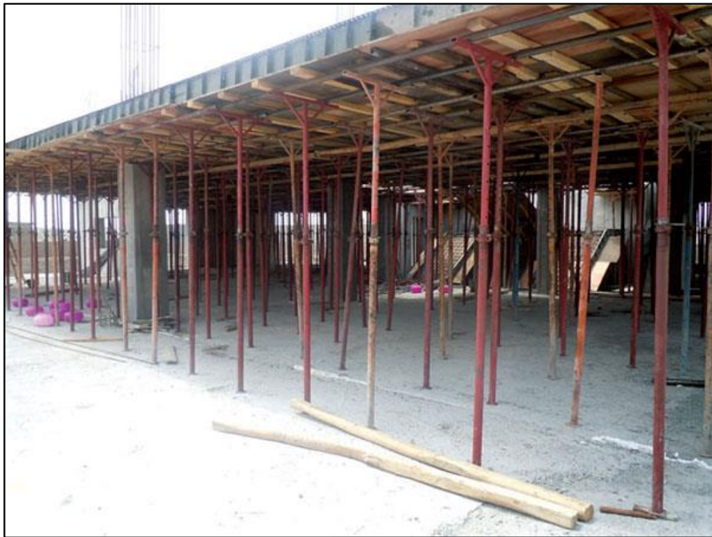
شکل ۱: نصب شمع‌های موقت
