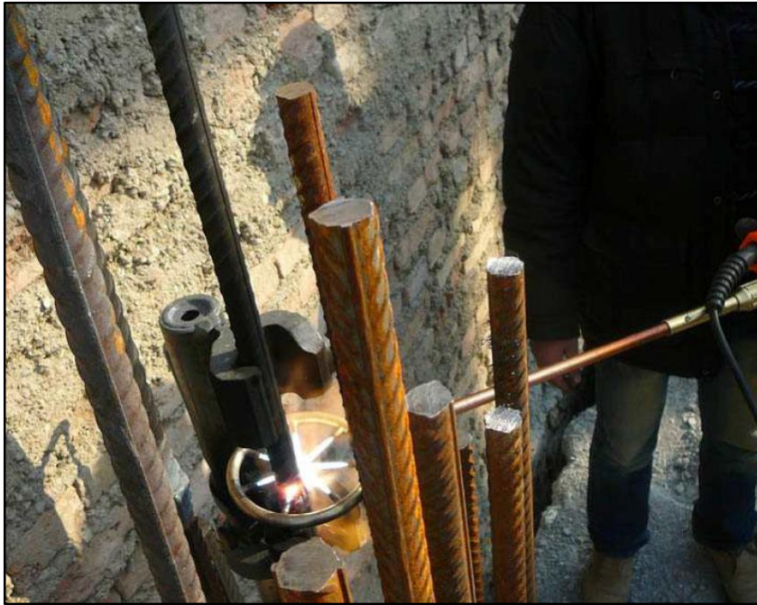
شکل ۴: اتصال میلگرد به روش فرجینگ
